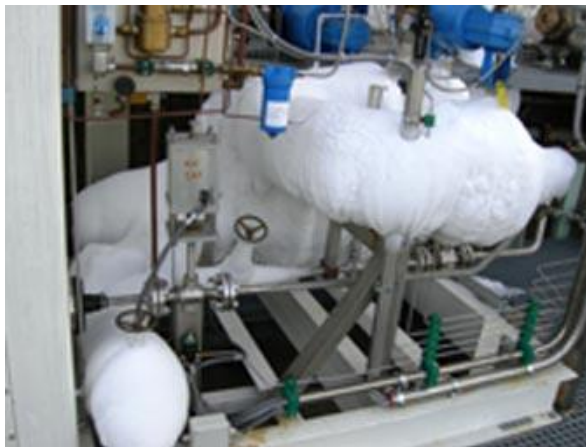
Zdjęcia 1,2: Mostki cieplne z/i bez odpowiedniego zaizolowania na przykładzie izolacji kriogenicznej.
