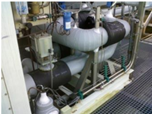
Zdjęcia 1,2: Mostki cieplne z/i bez odpowiedniego zaizolowania na przykładzie izolacji kriogenicznej.
